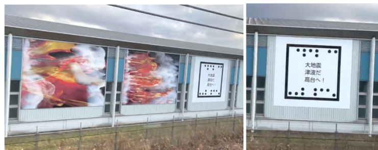
図 左：防災看板・AR看板の全景、右：AR看板
