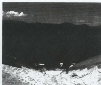
■中国有数の水力発電所である李家峡ダムは、今年1月に完成したばかりだ。
